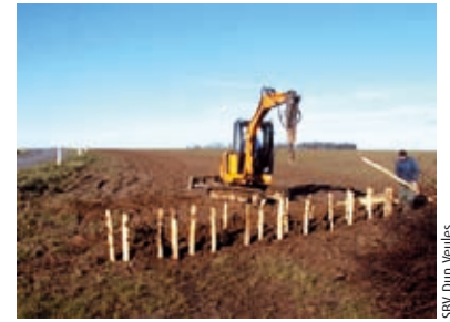
Battage des pieux
