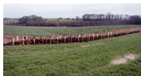
Placée en travers du ruissellement, la fascine le freine et provoque le dépôt des particules de terre
